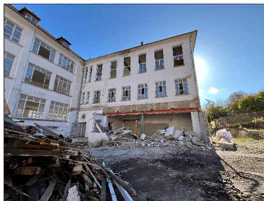
Rückbau der Industriebrache in Albstadt-Onstmettingen
