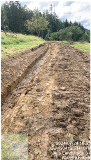
Entwässerungsgraben in Albstadt-Laufen
